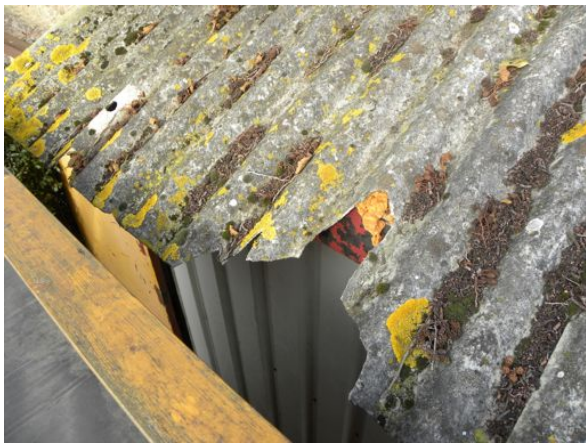
Afbrokkelend asbestdak
